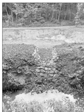
Hinter dem alten Bolzplatz in Dorgendorf wurde ein neues Löschwasserbecken mit 500 m<sup>3</sup> Fassungsvermögen fertiggestellt. Auch im Winter bei Vereisung ist eine Wasserentnahme möglich. Insgesamt 70.000 Euro hat die Stadt Baunach hier investiert.
