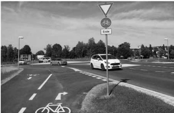
Bild 2: Höhengleiche Fahrbahnquerung eines Radweges [Quelle: topplan 2020]
