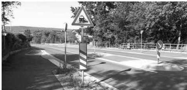
Bild 3: Höhengleiche Querungshilfe in Frensdorf [Quelle: topplan 2020] 5
